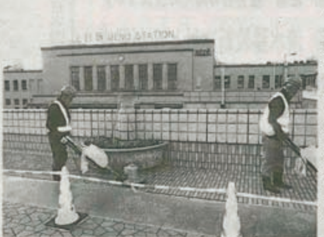
「上野」駅前で防汚工事風景
